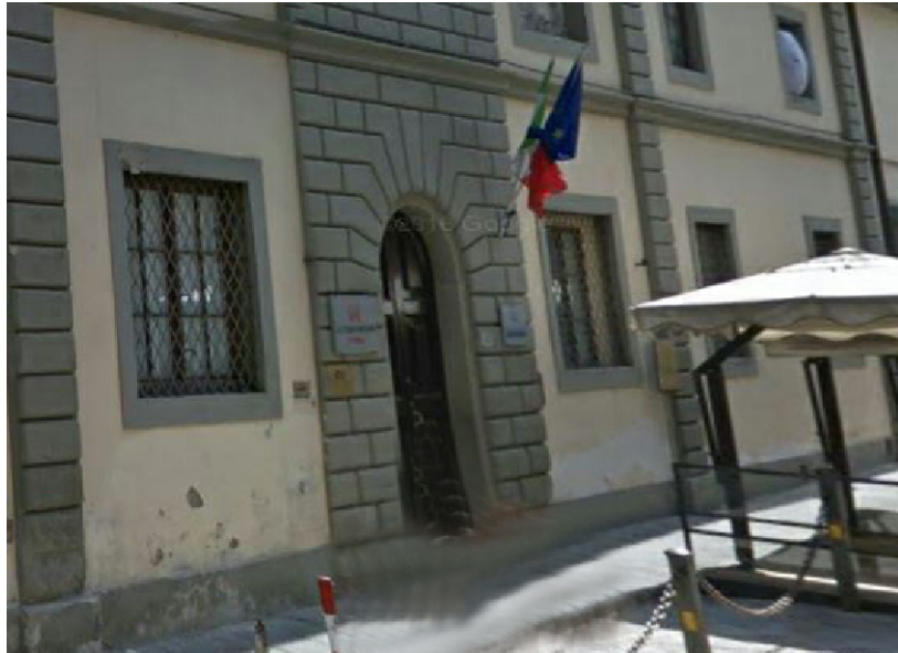
FOTO 1_ Ingresso da via Faenza, nc. 48
